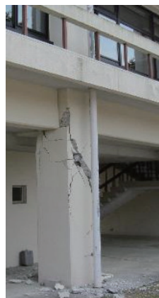
2階建校舎の1階の柱が被災した例
